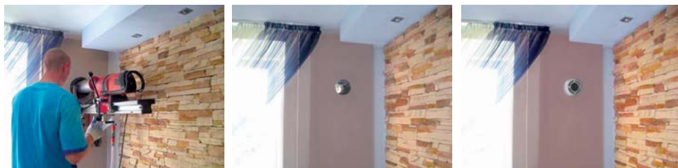
Slika 4. Primer vgradnje PRANA-150, PRANA-200G, PRANA-200C.
